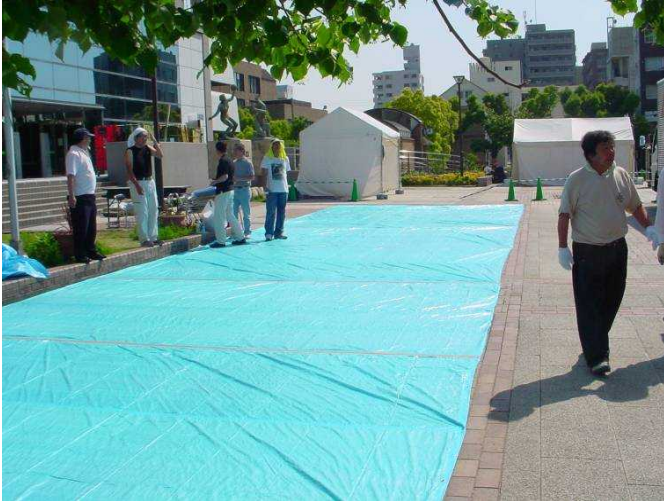
塩シート 200㎡ 敷設
